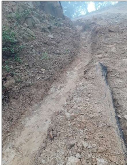
क्रमशःसडक पहिरो रोकथाम तथा कच्ची नाली निर्माण वडा नं -६
