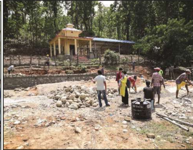
वडा कार्यालय भवन वडा नं ५ कम्पाउण्ड वाल निर्माण प्र. म. रोजगार कार्यक्रम
